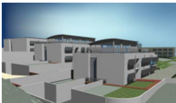
ΕΙΚΟΝΑ 5-2: Εποπτική εικόνα 2 των υπό κατασκευή κτιρίων του ΕΚΕΤΑ (το πρώτο είναι το κτίριο του IMET)
