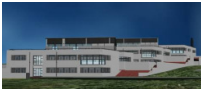
ΕΙΚΟΝΑ 5-1: Εποπτική εικόνα 1 των υπό κατασκευή κτιρίων του ΕΚΕΤΑ με το κτίριο του IMET μπροστά
